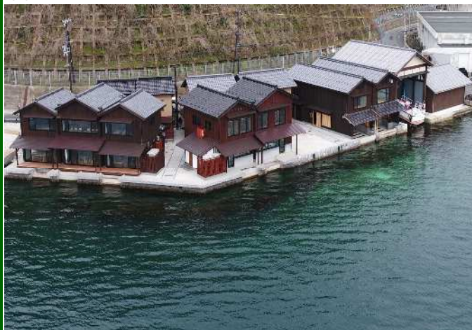
施工事例 舟屋
